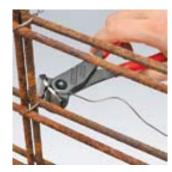
Также используются в монтаже арматуры железо бетонных конструкций
