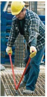
Особая форма головки ножниц для резки арматурной сетки 71 82 950 позволяет резать плотно прилегающую арматуру
